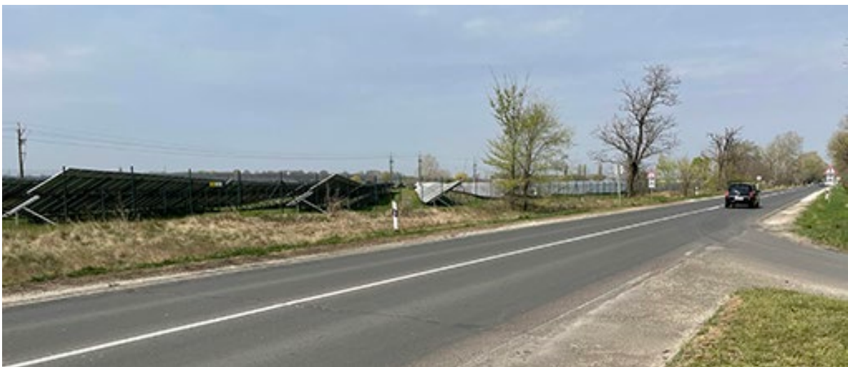
Megvalósult napelemparkok a 4 főút túloldalán
